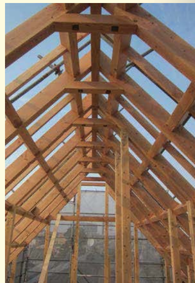
3階部分の木軸の架構が美しい。柱でなく、垂木の様な梁で屋根(壁)を形成。
