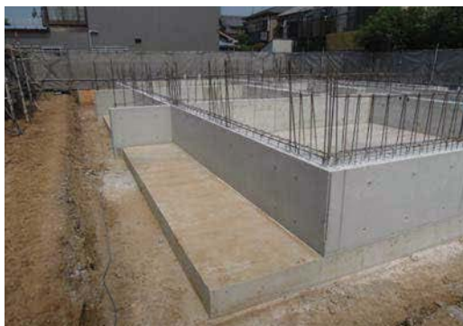
ベタ基礎で施工。“面”で建物を支えるイメージ。
