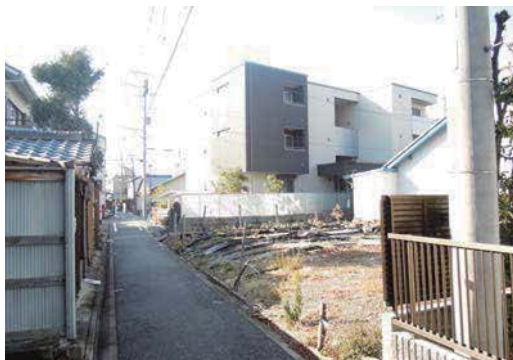
建設地。前面道路が2.4mと非常に狭い。
