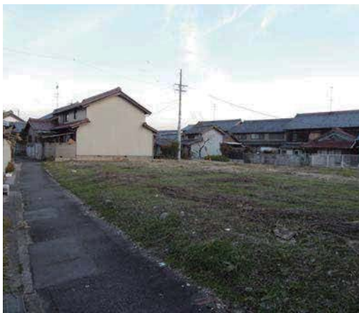
建設地。前面道路が狭く慎重に工事を進めた。
