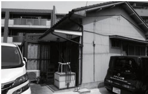
Before 改装前の平屋建ての母屋。
