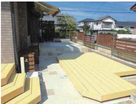
ウッドデッキとタイルでシンプルに仕上げました。
