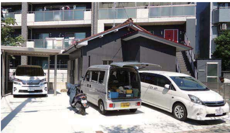
既設の屋根瓦を残し、外壁はガルバリウム鋼板で施工。南側に新たに駐車場を設けカーポートとフェンス、門扉を施工。
