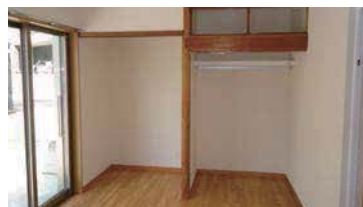
床柱や神棚は残し、サッシ、フローリングを新設。
