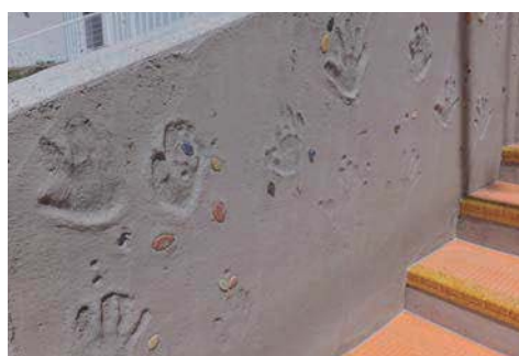
エントランス階段の壁面に子供たちの手形を記念に入れました。
