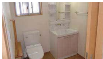
車イスで利用できるトイレと洗面台。間口を広くとり、手摺も付けました。
