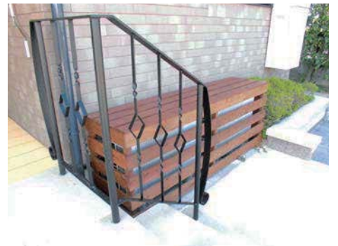
室外機隠しを木で製作し、上部は花を飾れる台を取付。
