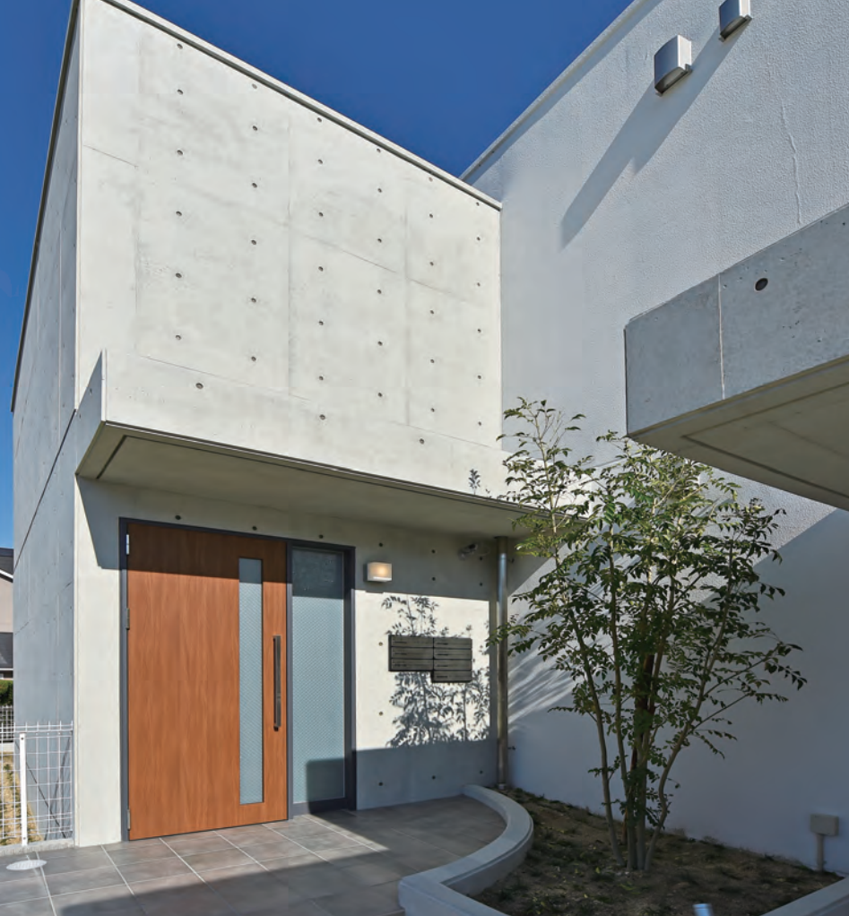
エントランスには植栽（シマトネリコ）を植え、木目調のドアと共にコンクリートのシャープさの中に柔らかさを入れ込みました。
