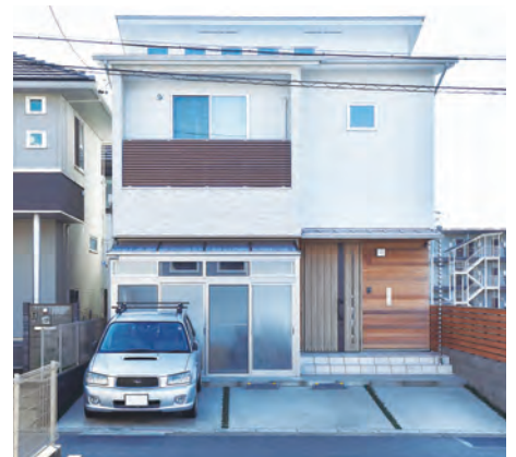
北側外観。敷地間口に対して目一杯の建物間口で設計しました。
