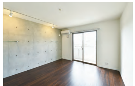
室内にもコンクリート打放し壁を採用。
