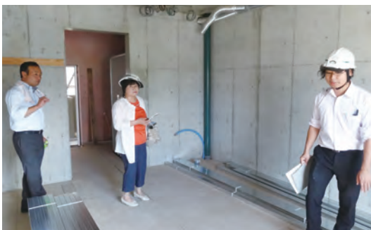
現場打合せ：施工中もオーナー様に確認して頂き、施工状況をチェック。
