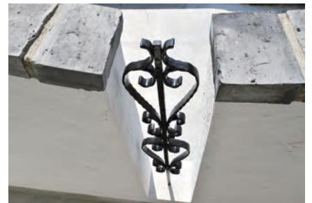
所々に使用している鋳物のアクセント。無骨なデザインが、更にブルーのタイルや白の塗壁を引き立たせます。
