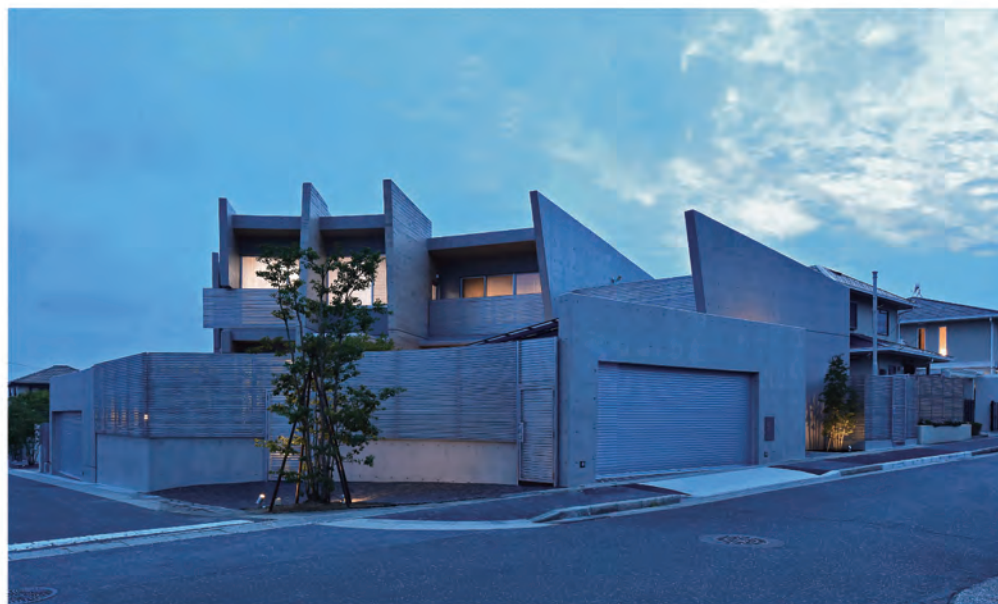
年月を経てグレーに変わる溶融亜鉛メッキを施されたスチームフェンスとコンクリート打放し。構成要素はこの2つ。
