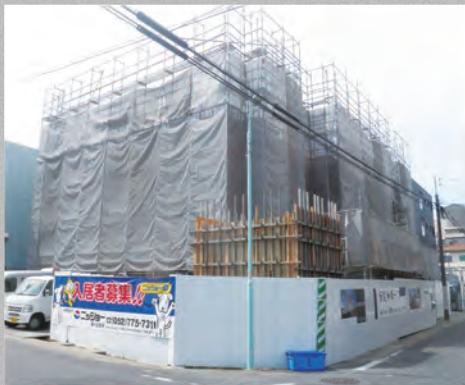
新築工事施工
