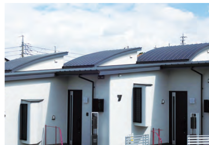
西面ファサード。左官の外壁とR屋根による動きのあるデザイン。
