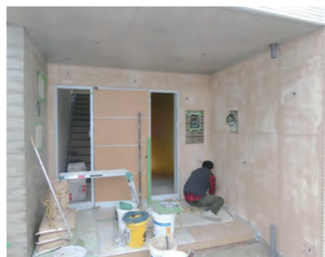
左官施工(下塗り)
