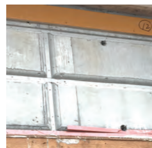
型枠の脱型
