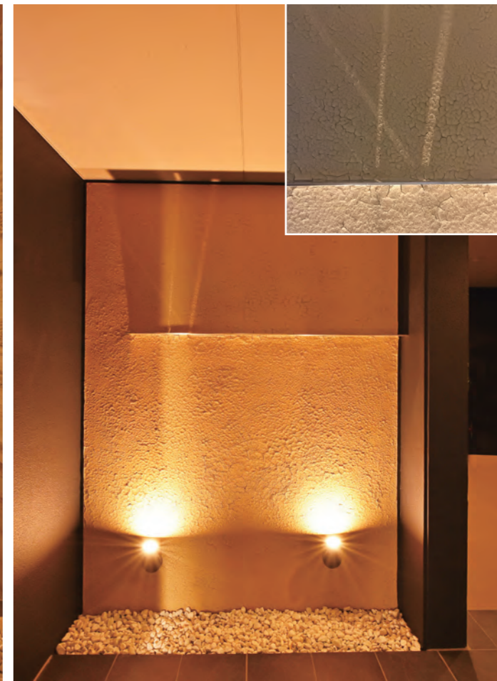
特徴的なひび割れ仕上げ(右上の拡大写真)の左官を横に進む。
