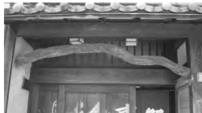
エントランスにあった既存の化粧梁。内装で是非活かしたい!
