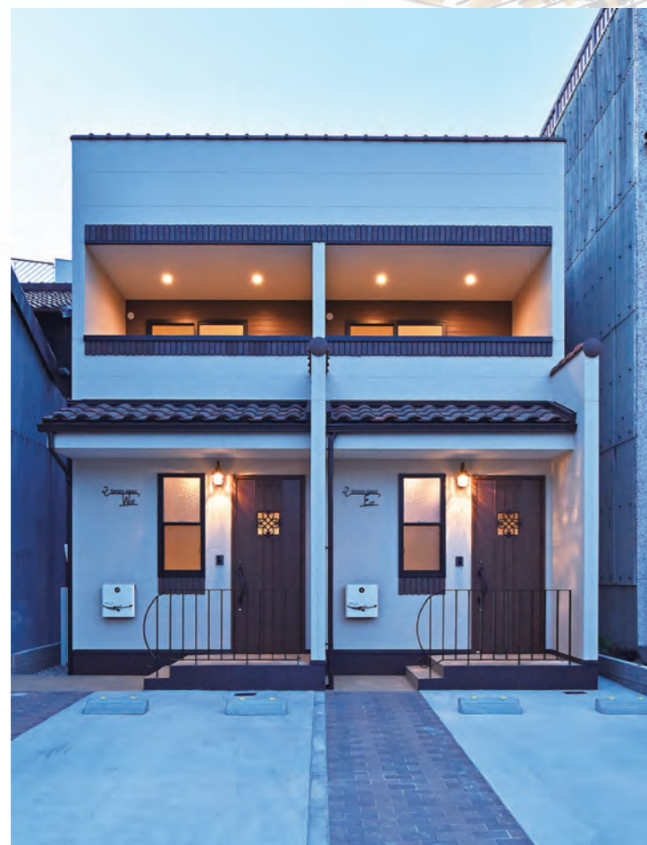
東海・ビルドの木造賃貸シリーズ「風遊館(ふうゆうかん)」初の2戸並び。コンパクトの中にも洋瓦やアイアンでアクセントをつけ、柔らかい印象の外観を演出。
