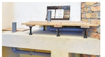
床のモックアップ(原寸サンプル)を設置。二重床と直貼りを比較できます。
