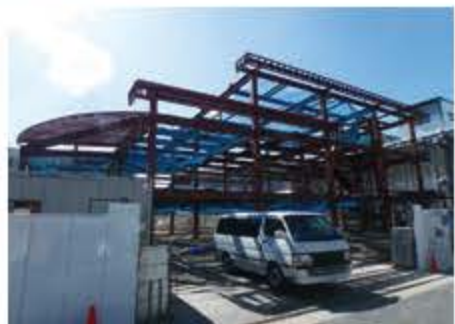
鉄骨の建て方 5層以上級すると一気に工事が進みます。
