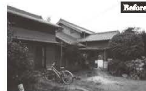
左はリノベーション前の写真。屋根を壊しつつ必要に応じて増築し、必要部分を増築しました。増築部分の位置を、片流れの屋根に合わせ、ハイサイドライトから光を取り込みます。
