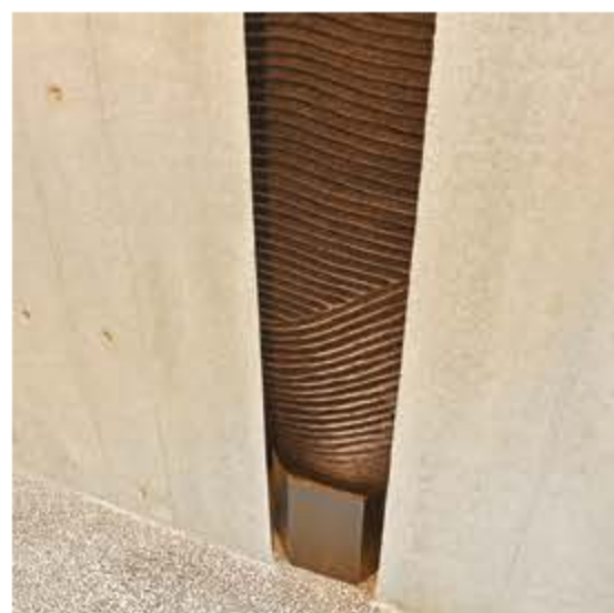
エントランスアプローチに設置のスリット照明です。
