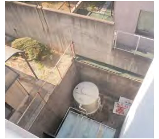
北西の隣地とは高低差があり擁壁で囲われていた。
