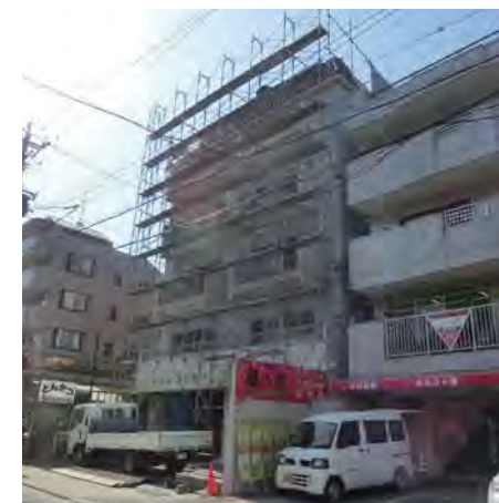
解体工事着手[足場設置工事]
