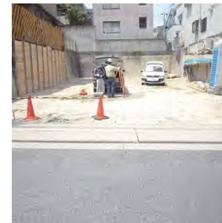
土留め工事完了
