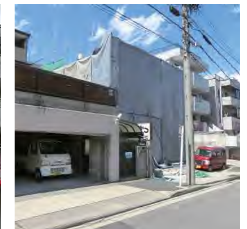
建物上部解体工事
