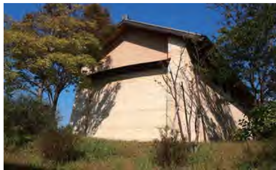
土・どろんこ館 / 版築と呼ばれる土をしめ固めた外壁で造られている。
