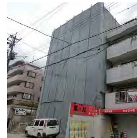
足場設置完了後、仮設養生シート設置
