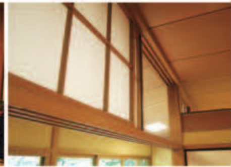
お茶室の風景。よく見ると障子が障子だけで納まっています。すっきりした作りです。高級しんしの丸太で上から吊り下ろしてあります。発煙や施工力に感謝。50年前の建物ですよ、これ!
