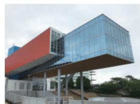
手前右側のオレンジの箱がスロープになっており、そのスロープが海に向けて伸びている。海に伸びた先のガラス張りの箱は約70m宙に浮いている。まさに日本から世界へ飛ばたく龍馬の精神を象徴しており、とても思い切りの良い建物。支柱からケーブルで吊る事でこれだけ飛び出す事を可能にしている。なんとこれだけ大きな建物でも屋上でジャンプすると揺れる揺れる。壊れないから心配しないでください!
